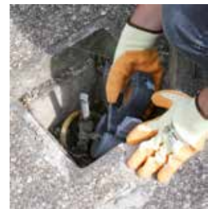
Die elliptische Zange erleichtert das Umfassen in engen Verhältnissen
